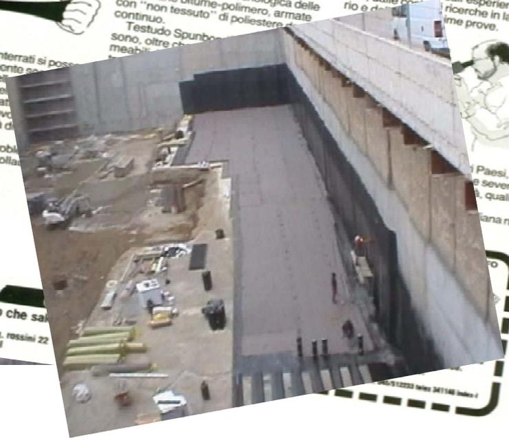
Lo studio sul **comportamento delle membrane INDEX** per l'impermeabilizzazione delle fondazioni degli edifici **nel caso di evento sismico**, ha condotto all'individuazione di un sistema di posa che non solo garantisce l'integrità del rivestimento nel caso di terremoto ma anche isola l'edificio dalle scosse sismiche, studio, a nome del Prof. Chesi del Politecnico di Milano e A. Ugolini, presentato nel 1985 al congresso AIE di Londra
