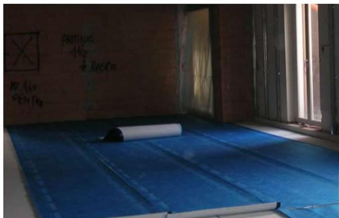
Isolamento acustico realizzato mediante pavimento galleggiante
